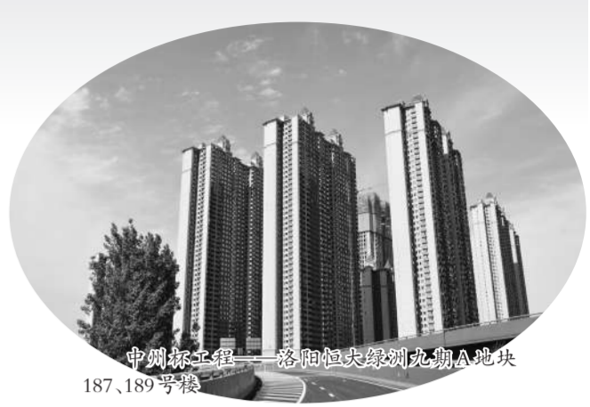
中州杯工程——洛阳恒大绿洲九期A地块187、189号楼
