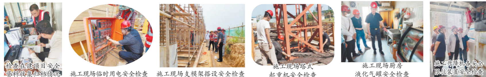
检查在建项目安全资料收集归档情况 施工现场临时用电安全检查 施工现场支模架搭设安全检查 施工现场塔式起重机安全检查 施工现场厨房液化气罐安全检查 施工升降机安全限位装置安全检查
