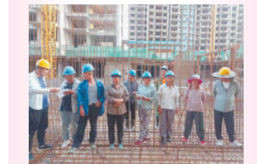
科技分公司焦作恒大翡翠华庭项目
